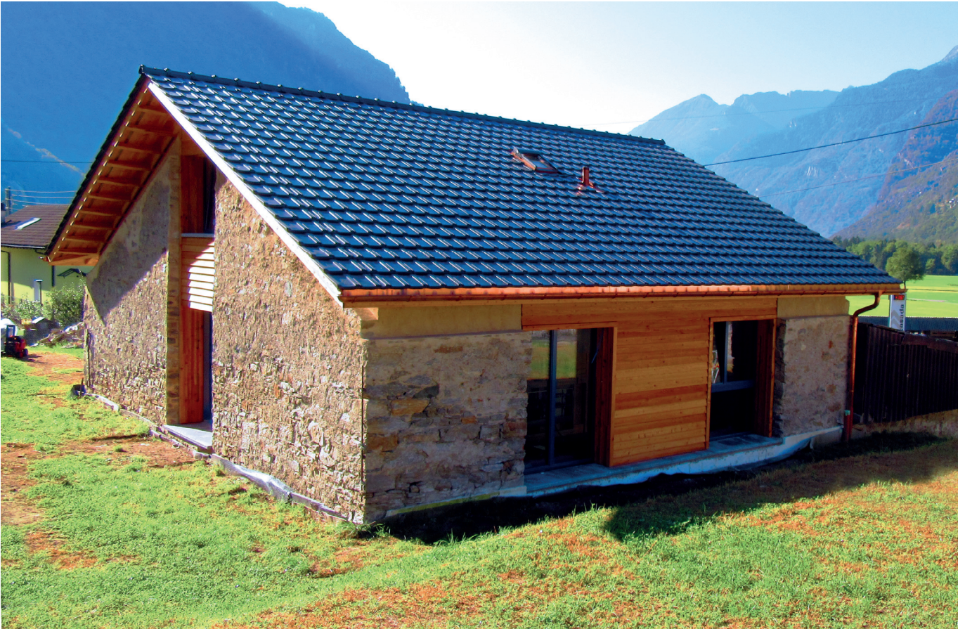
L'ex stalla ora si presenta come edificio residenziale
