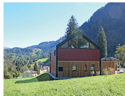
Rivestimento verticale in legno sul lato posteriore della casa
