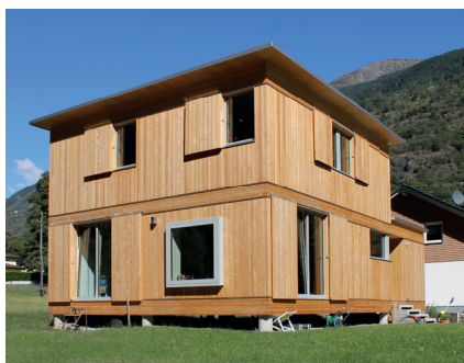
Vista del lato ovest dell'edificio di forma cubica
