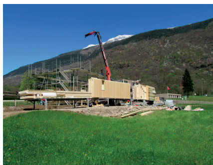
Il montaggio della costruzione modulare in legno è in corso
