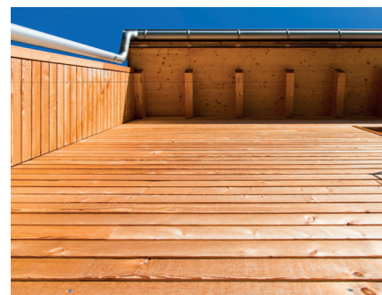
Facciata con vista del lato inferiore della struttura del tetto
