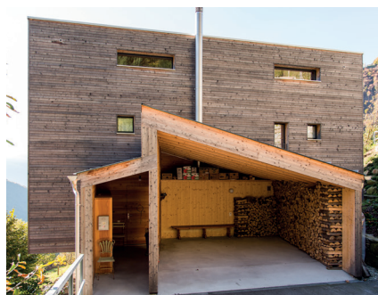
Vista dal lato nord
