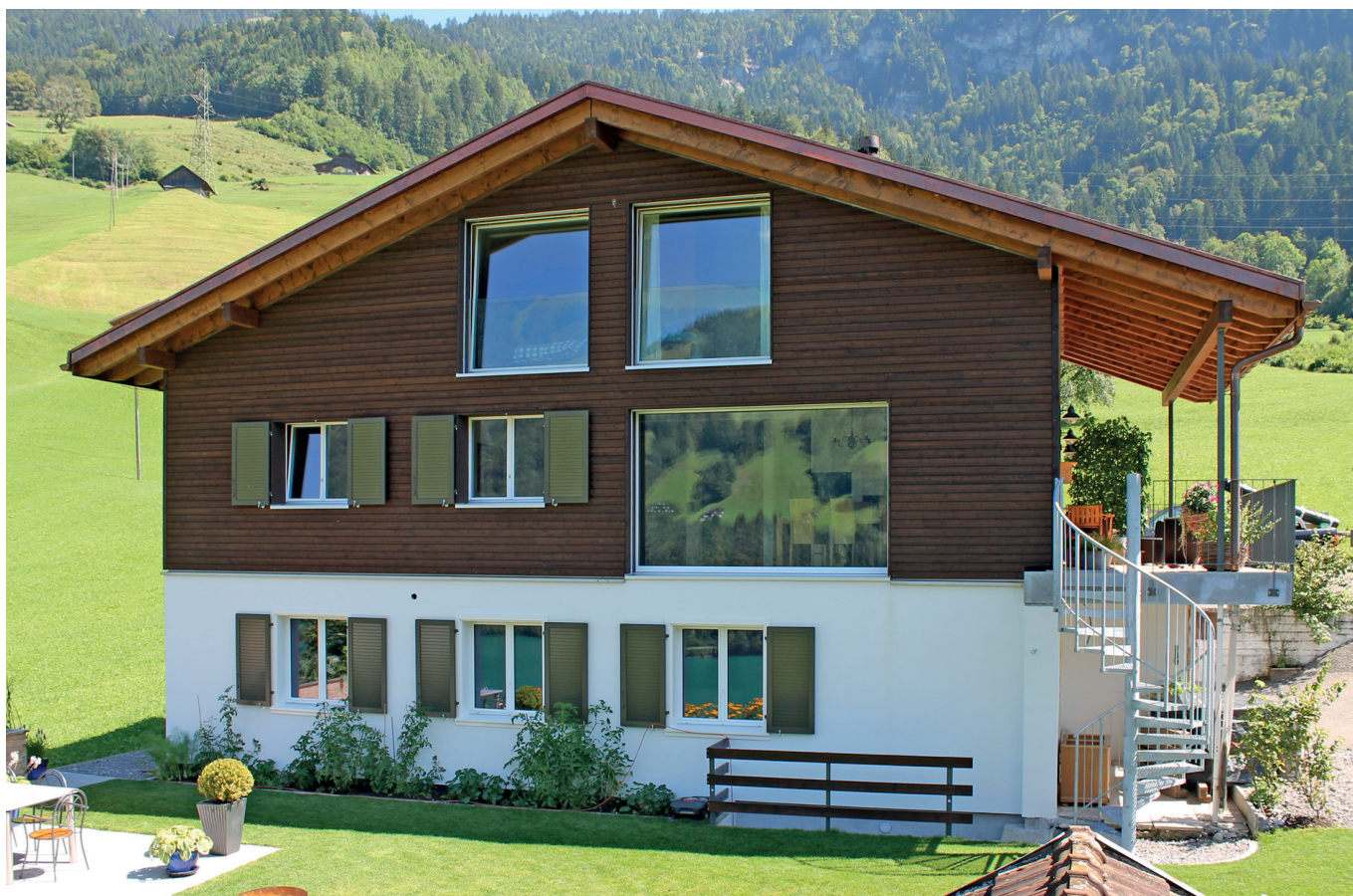
La facciata ovest come lato frontale principale con ampie vetrate
