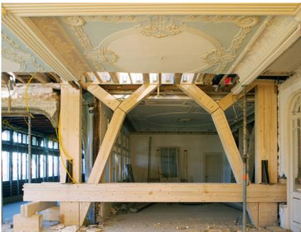
Fachwerke montiert zwischen historischen Decken zur Aussteifung des Gebäudes (Erdbebensicherheit).
