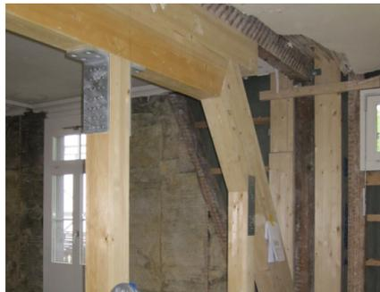
Eingebautes Sprengwerk mit Hängepfosten. Abgebunden und angepasst vor Ort.
