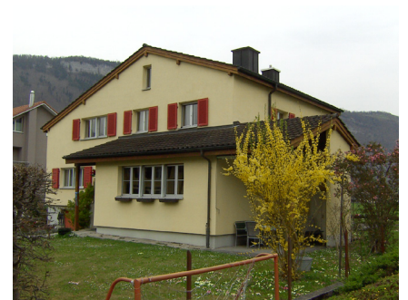
Das Gebäude vor den Umbauarbeiten
