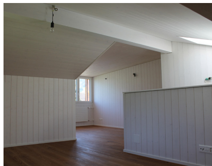
Neu ausgebautes Dachgeschoss in Holz
