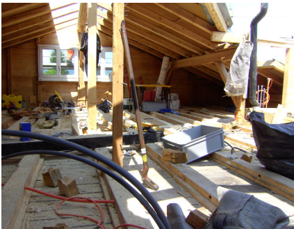
Das Dachgeschoss in der Bauphase
