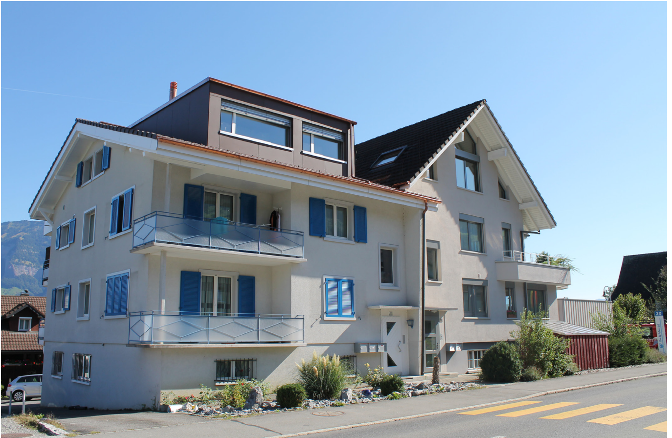
Das Gebäude nach dem Um- und Aufbau
