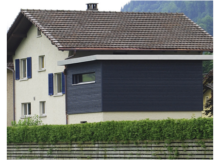
Der Anbau aus der Ferne betrachtet
