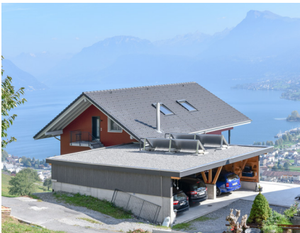
Carport in Holzbauweise
