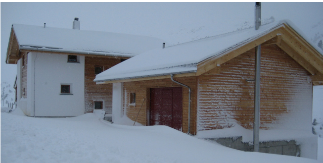
Hohe Beanspruchung der Fassade im Winter
