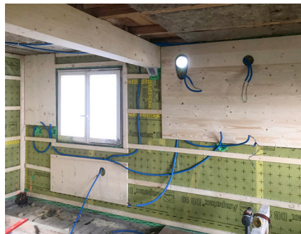
Dampfbremse und Installationsrost
