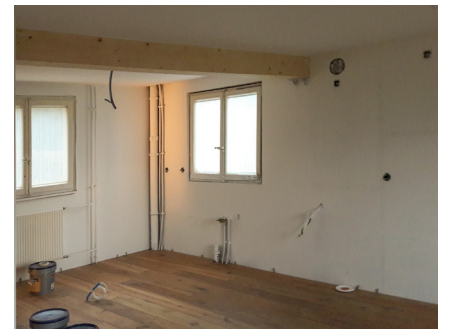
Gipsfaserplatte gespachtelt und gestrichen
