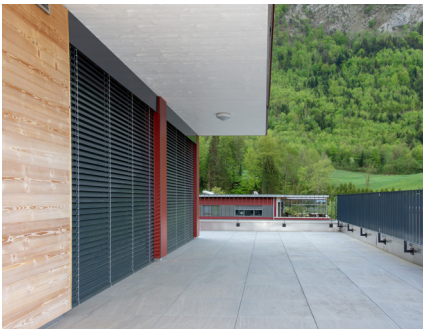
Westbalkon mit Holzdecke
