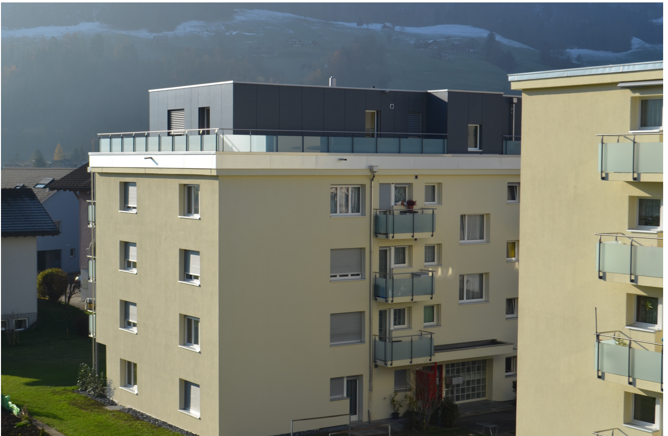
Aufstockung in Elementbauweise
