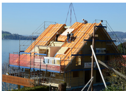
Edificio abitativo, Kehrsiten, NW
