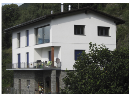
Edificio abitativo, Artore, TI
