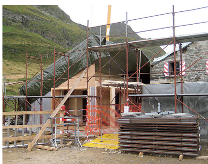
Componente vecchio e nuovo nella fase costruttiva
