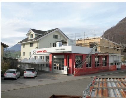
Wohnungsaufbau während Montgearbeiten
