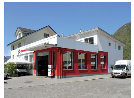
Wohnungsaufbau nach Bauende
