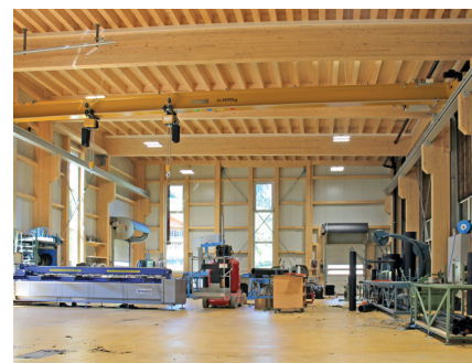
L'interno del nuovo capannone
