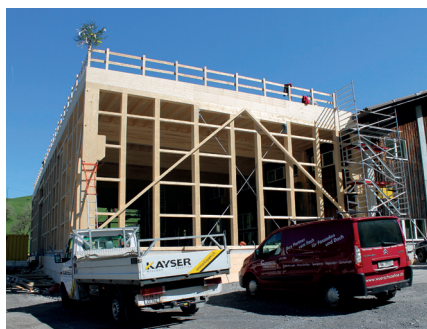
Il nuovo edificio annesso nella fase di lavorazione grezza
