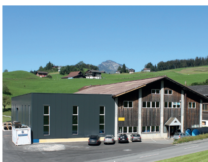
Il rivestimento della facciata completamente montato
