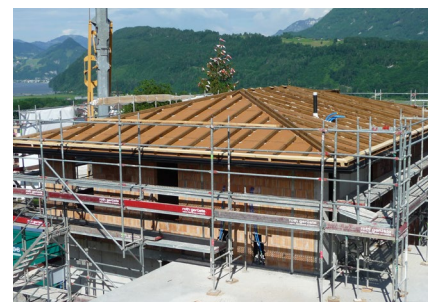
Fotos: Kayser Holzbau AG
