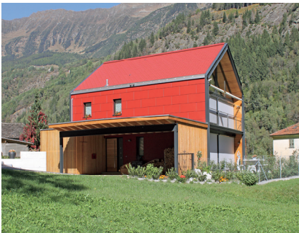
Hauszugang und Carport
