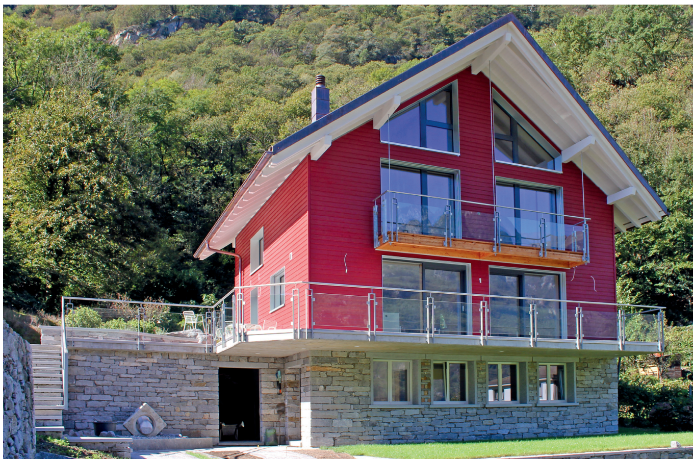
Il lato ovest dell'edificio con seminterrato
