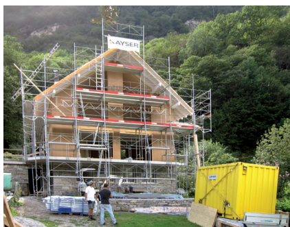
L'edificio dopo il montaggio della struttura in legno
