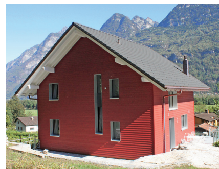
Lato posteriore della casa unifamiliare dopo il completamento
