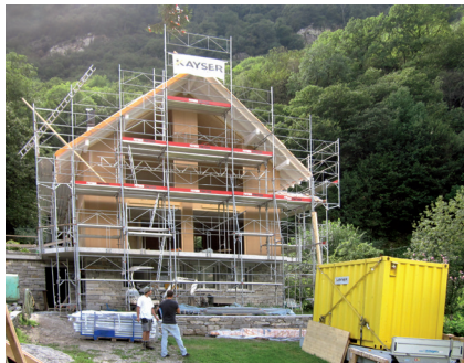
Das Gebäude nach der Montage des Holzbaus
