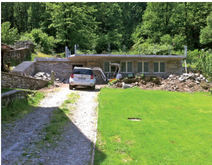
Der Bauplatz mit Sockelgeschoss vor der Montage des Holzbaus
