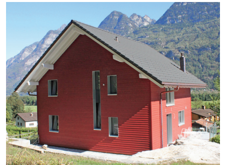
Rückseite des Einfamilienhauses nach der Fertigstellung
