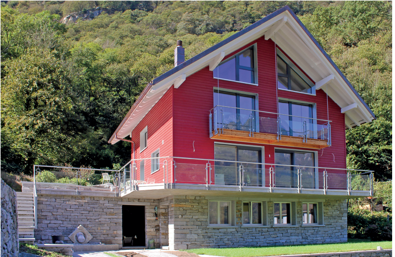
Die Westseite des Gebäudes mit dem Sockelgeschoss
