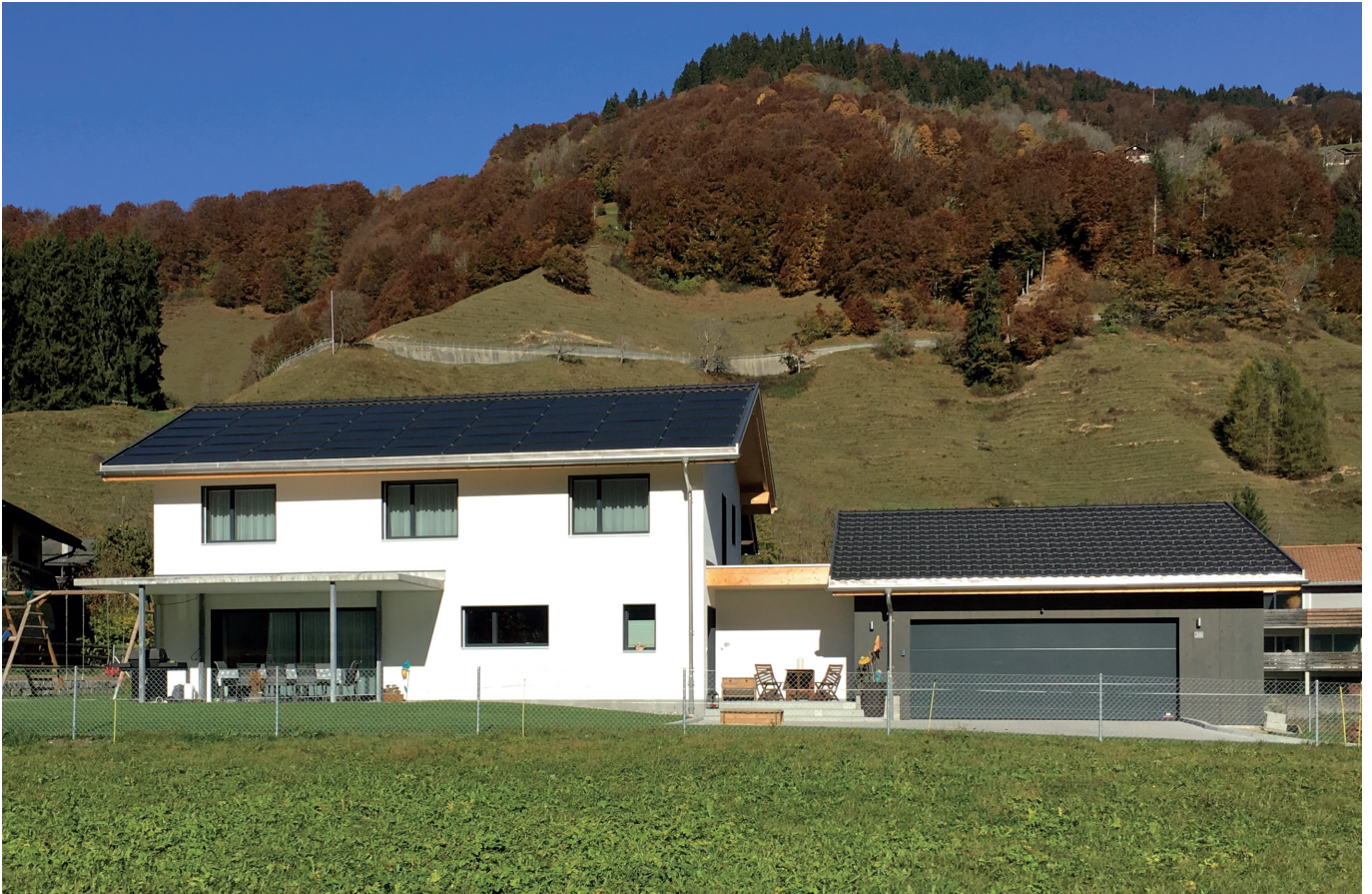
Die Südfassade mit den gut erkennbaren drei Gebäudeteilen
