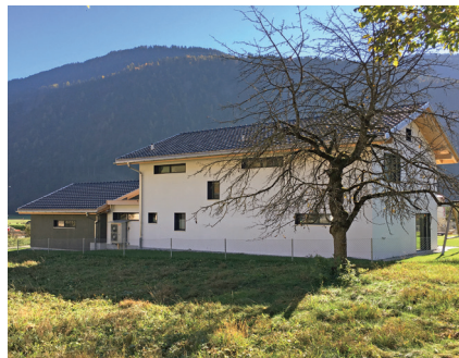
Gebäude in der Nordansicht
