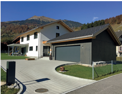
Hauptgebäude mit Garage in der Südostansicht
