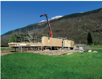
Die Montage des Holzsystembaus ist im Gange
