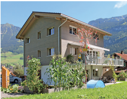
Vista sulla casa dal lato ovest
