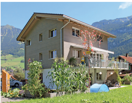
Der Blick auf das Wohnhaus in der Westansicht
