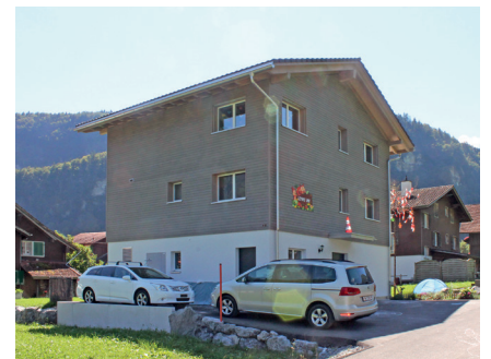
Blick von Nordwesten auf das Gebäude mit dem Eingang
