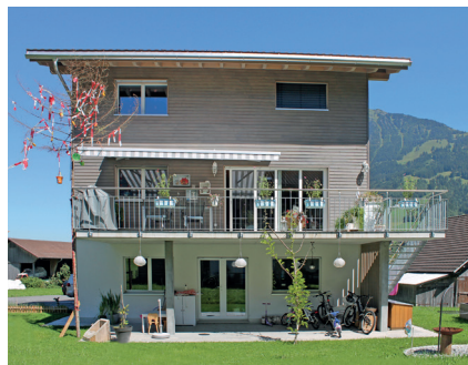
Die Südwestfassade, im Erdgeschoss befindet sich eine Kleinwohnung
