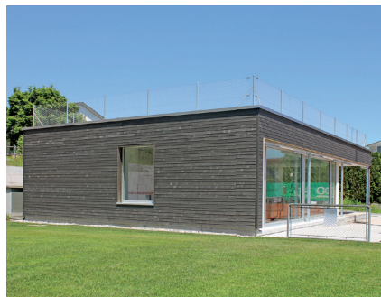
Die Südfassade zum Fussballplatz und die Glasfront zu den Tennisplätzen Richtung Osten
