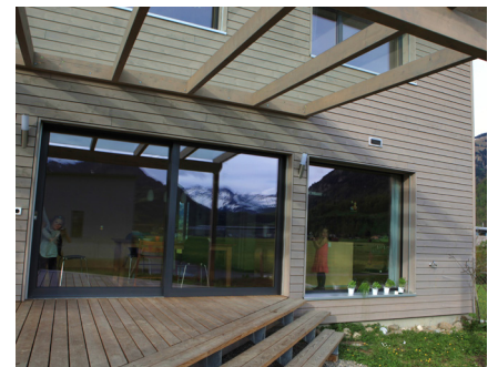
Vom Haus aus führt das Holzdeck direkt in den Garten
