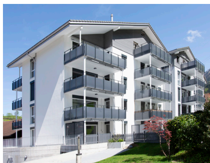
Vista dal lato sudovest
