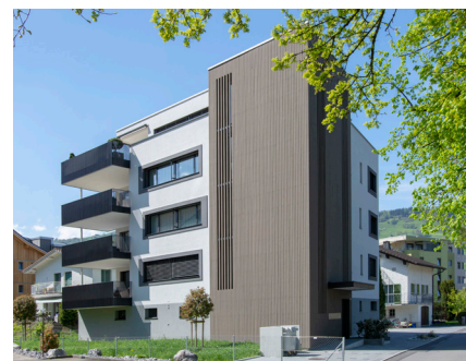
Vista dal lato sud e zona d'ingresso
