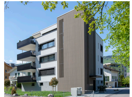
Südansicht und Eingangsbereich
