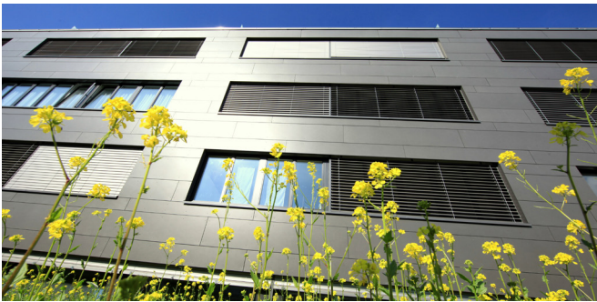
Fassade mit Zementfaserplatte
