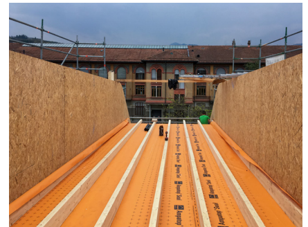
Innenansicht des neuen Daches
