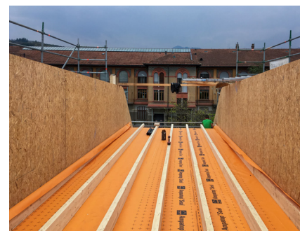
Vista interna del tetto messo a nuovo
