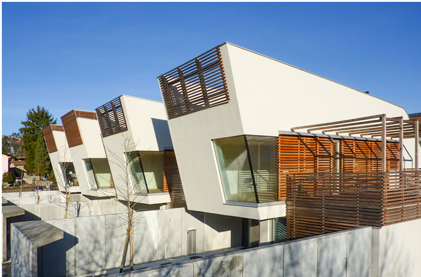
Vista completa degli edifici prima dell'incendio
